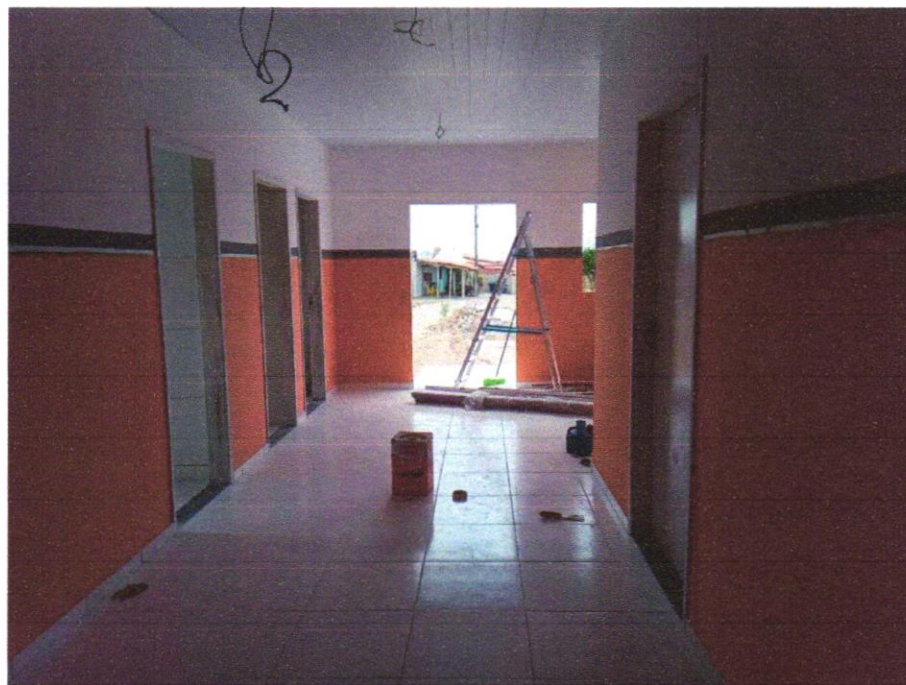
Foto 09 - Forro de pvc, em régulas de 10 ou 20 cm, aplicado, inclusive estrutura para fixação (perfis em PVC) marca Araforros ou similar, instalado - Rev 06_10/2021
