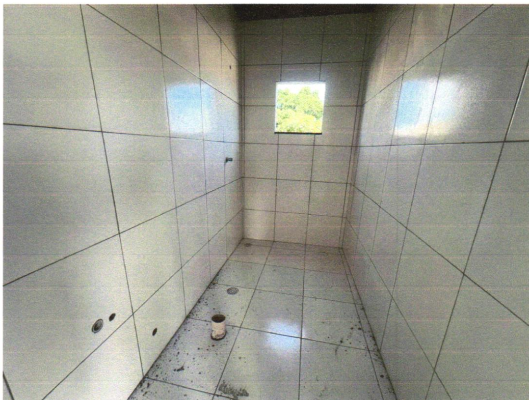
Foto 03 - REVESTIMENTO CERÂMICO PARA PISO COM PLACAS TIPO ESMALTADA EXTRA DE DIMENSÕES 45X45 CM APLICADA EM AMBIENTES DE ÁREA MAIOR QUE 10 M2. AF_06/2014
