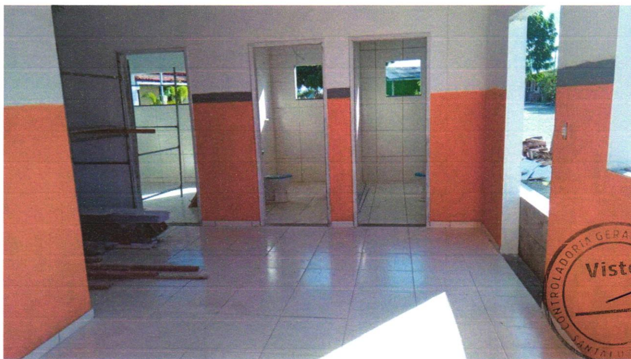
Foto 04 - REVESTIMENTO CERÂMICO PARA PISO COM PLACAS TIPO ESMALTADA EXTRA DE DIMENSÕES 45X45 CM APLICADA EM AMBIENTES DE ÁREA MAIOR QUE 10 M2. AF_06/2014
